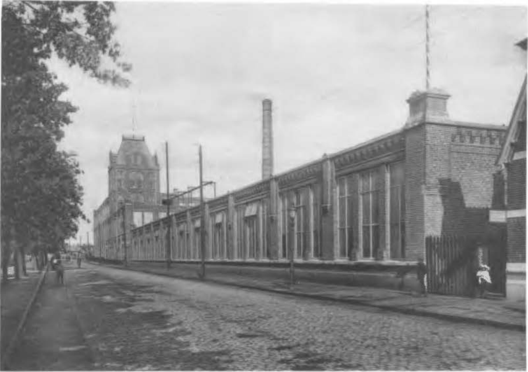
foto 1 Fabriek van Gerh. Jannink & Zonen aan de Haaksbergerstraat te Enschede. Gebouwd in 1900-1901. In het hoge bouwdeel met de watertoren bevonden zich de spinnerijzalen; de shed-konstruktie van de weverij op de voorgrond gaat schuil achter een muur, waarvan de ramen in later tijd werden dichtgemetseld. In de hoogbouw is sinds enige jaren het textielmuseum gehuisvest. Archiefphoto omstreeks 1915.
