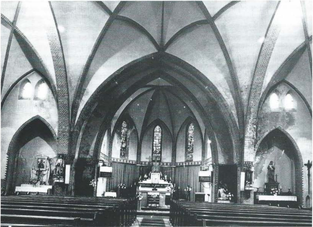
H. Antonius, Zwartemeer (Dr.), naar het oosten, eerste steen 1920. Architect: Joh. Sluijmer sr.
