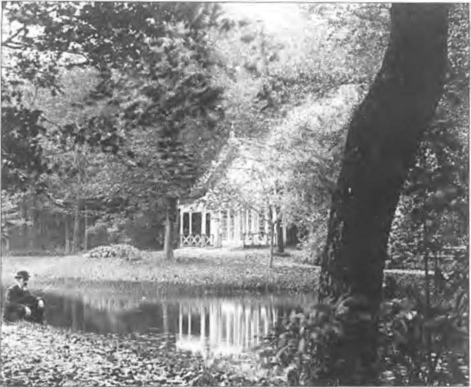
Het romantische theehuisje op 'de Welle' in 1858 gebouwd en honderd jaar later afgebroken. Op de voorgrond Bernard Jan Blijdenstein (1876-1953) in gepeins verzonken.
