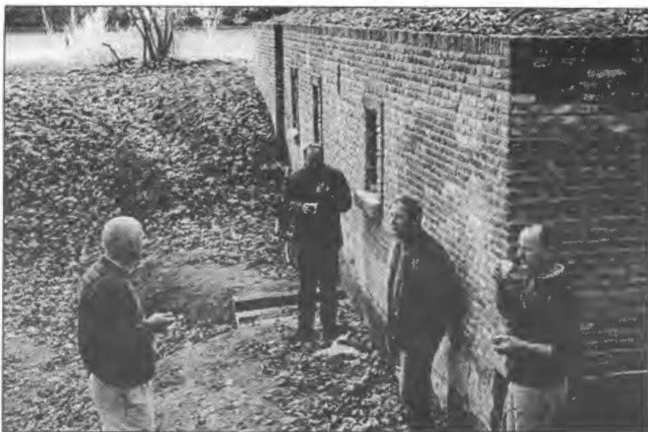
Het karwei zit er op. De donkere plekken in de muur geven de plaatsen aan waar de resten van de oude muur zitten. Van links naar rechts: Dinant Imhof, Mannes Konijnenbelt, Adrie Twilhaar en Johan ten Dam (Foto Johan Alferink, 8 november 1997)
