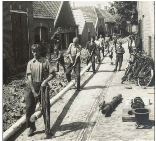
Aanleg van waterleiding aan de Huttenwal in Rijssen, 1936. De buis wordt in de geul getild.
