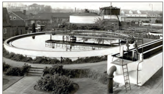
Gemeentelijke rioolwaterzuiveringsinstallatie aan de Vissedijk in Almelo, 1951. Bron: Gemeentearchief Almelo.
