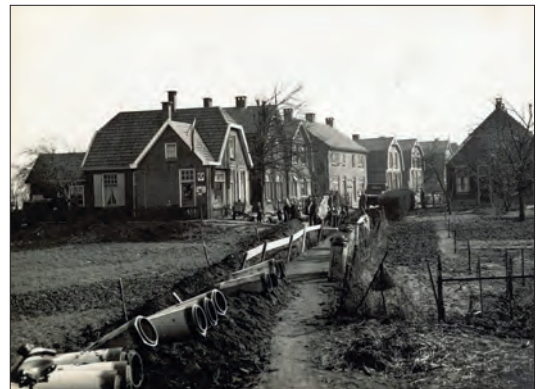
Aanleg van riolering aan de Holtentorensweg in Rijssen, jaren '30.
