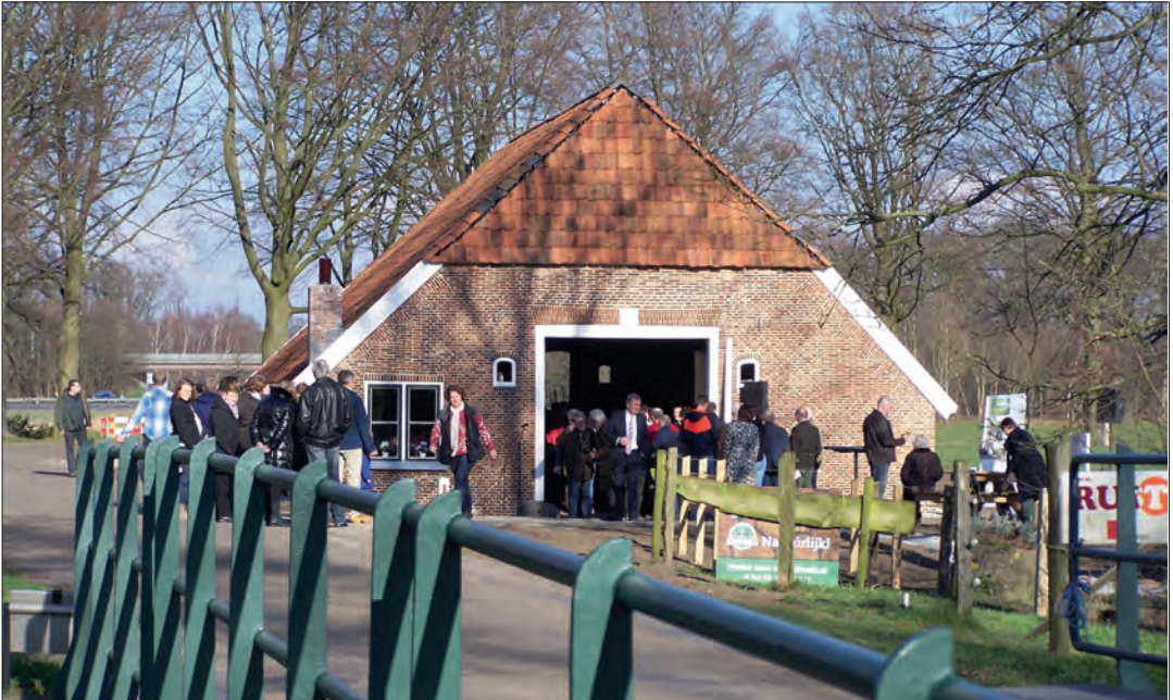
De gerestaureerde doorritschuur op het erf Binnengait. Bij de restauratie werden muren opnieuw opgemetseld en werd de hele dakconstructie gerestaureerd.
