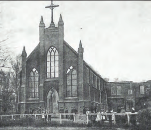
De verwoeste rooms-katholieke kerk met pastorie na de Grote Brand in 1905. Deze werd gebouwd in 1858. Het eerste kerkje uit 1797 waar de rellen zich voordeden, stond op dezelfde plaats aan het Westeinde, ongeveer 80 meter van de weg afgelegen. Uit: Ken uw dorp en heb het lief.
