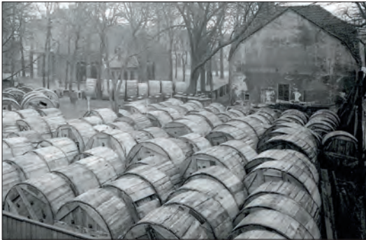
Opslag laagspanning kabel bij het H.J. van Heekplein.
