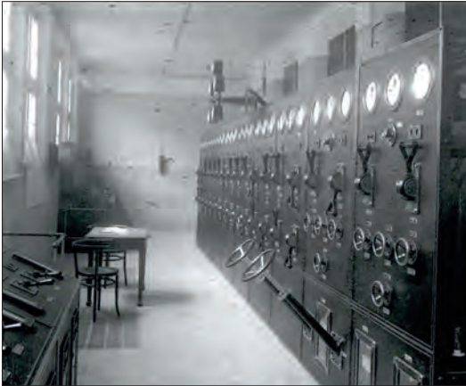
Interieur van het in 1916 in Enschede gebouwde onderstation.
