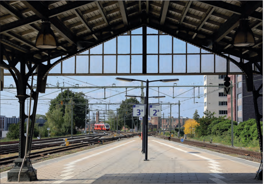
De elektrificatie van het spoor in Twente is nog steeds niet voltooid. Blik vanuit knooppunt Hengelo. Links de diesel op weg naar Zutphen. De rechter tak van het spoor voert langs Hazemeyer naar Almelo.
