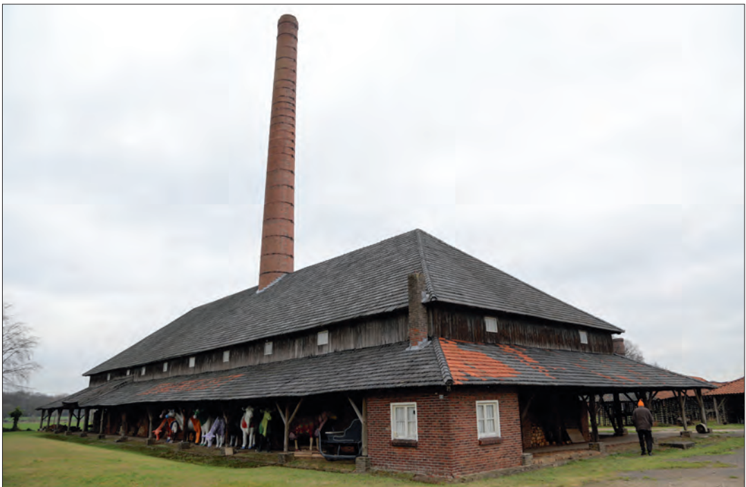
De steenfabriek van de gebroeders Osse in Losser. Eén van de laatste voorbeelden in Europa van een nog functionerende ringoven. De productie werd in 1999 beëindigd.
