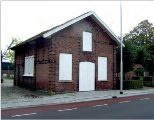
De synagoge in Vriezenveen gaat onderdeel uitmaken van een verzorgingshuis. De buitenzijde wordt in de originele staat van 1878 teruggebracht.
