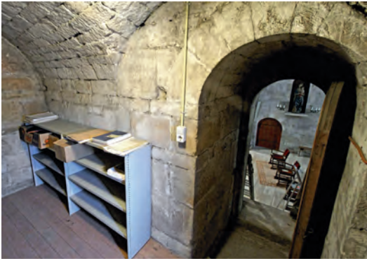
St. Plechelmusbasiliek, bovenverdieping van de romaanse koorhoekdubbelkapel. Deze twaalfde-eeuwse, met massief zandsteen overwelfde ruimte was bewaarplaats van onder meer stadszegels en privilegebrieven, opgeborgen in een ijzeren kist met meerdere sloten. Foto Carlo ter Ellen, juni 2021.
