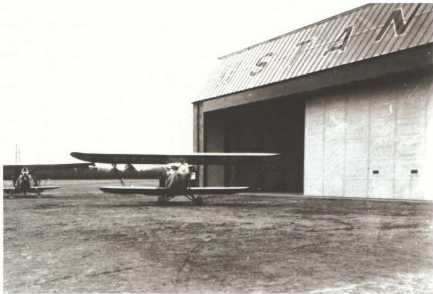
1935, de hangar met twee vliegtuigen
